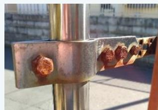
写真1 ボルトの腐食
