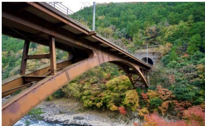
図1 耐候性鋼製の鋼橋（製造タイムズより）
