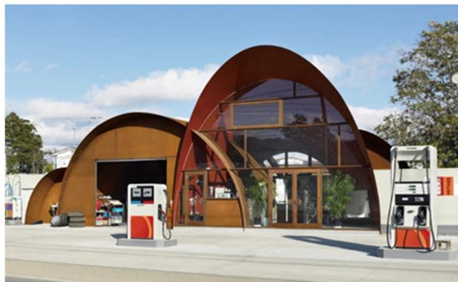
図2 気仙沼市のシングル鋼板アーチ工法耐候性鋼素地仕上げで建築されたガソリンスタンド（（株）高橋工業様HPより）
